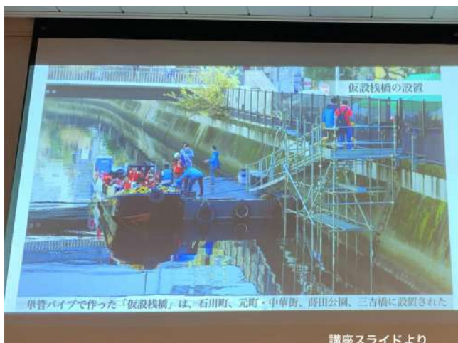
単管による仮設栈橋を設置(実証実験)
