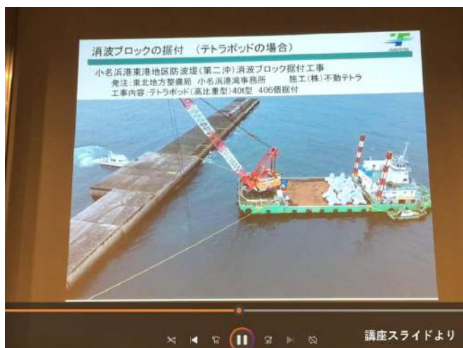
海上からのクレーンによる設置
